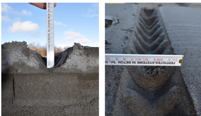
Resalith løsning kan i mange tilfælde erstatte forskalling og kantstøbning
